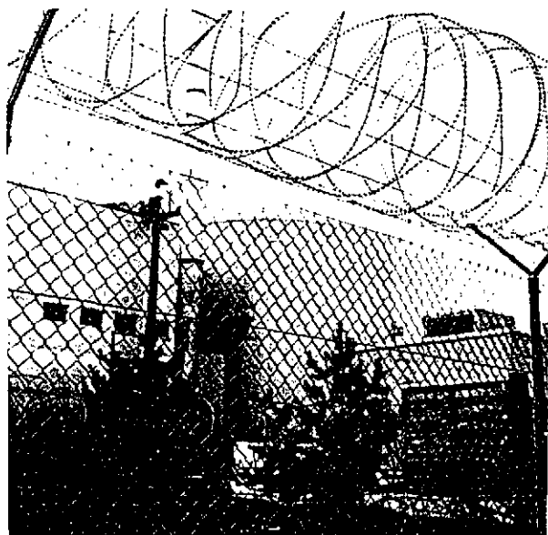
Objektschutzmaßnahmen bei KNK
