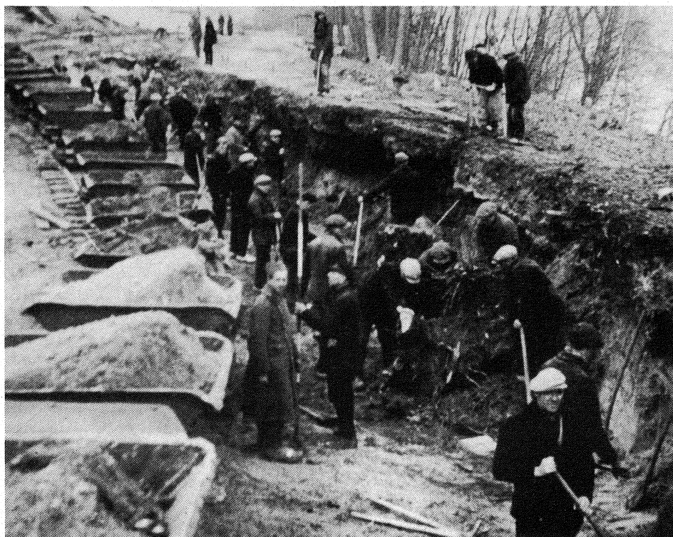
Erdarbeiten für das HEW-Kraftwerk.
