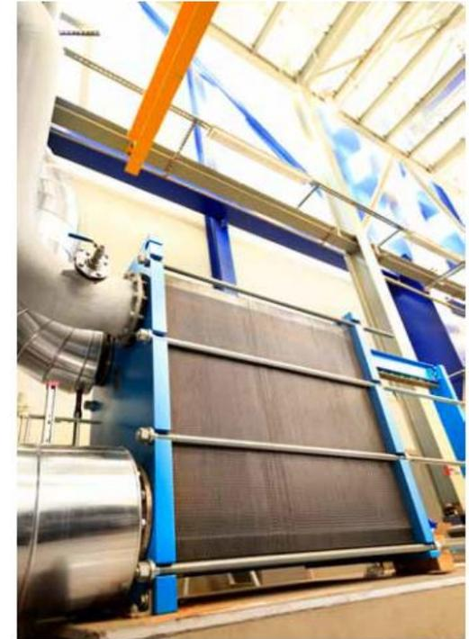
Kondensator zur Fernwärmeauskopplung SYSAV Malmö
