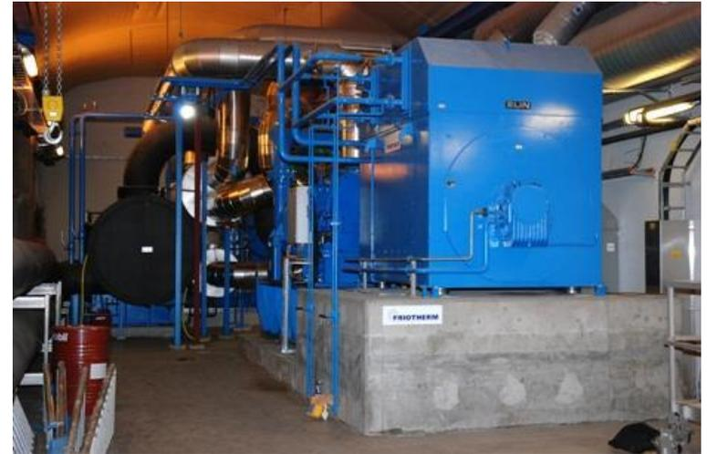
Abwasser-Wärmepumpe Friothersm Fernwärmeversorgung Oslo
