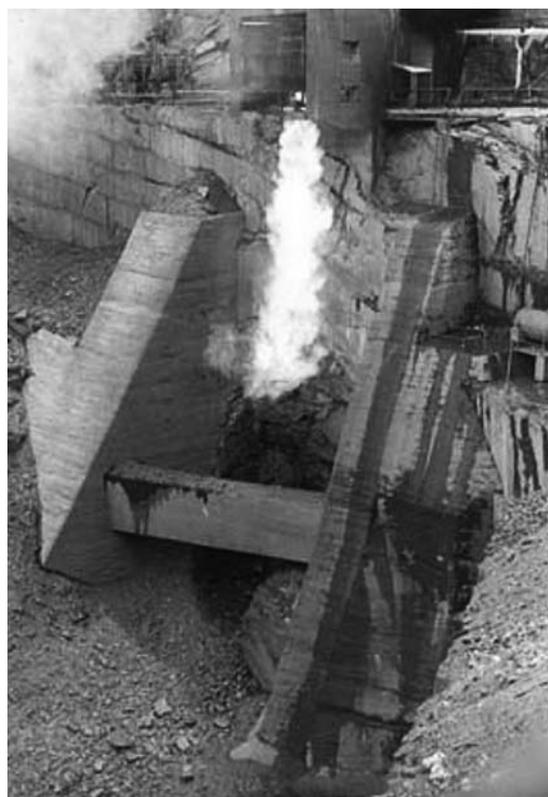
Die Schiefergrube Oertelsbruch eignete sich ideal für das Testen der V2-Triebwerke. Entlang der durch den Abbau entstandenen Schrämwand konnten Prüfstände angebracht werden, ohne dass Abgasumleiter eingebaut werden mussten. Ein Original-Triebwerk der A4 ist im Museum der Gedenkstätte Laura ausgestellt.
